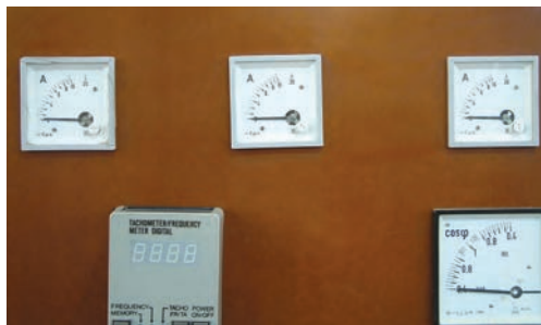
شکل ۶-۱۱- آمپرمترهای اندازه‌گیری جریان فازها
